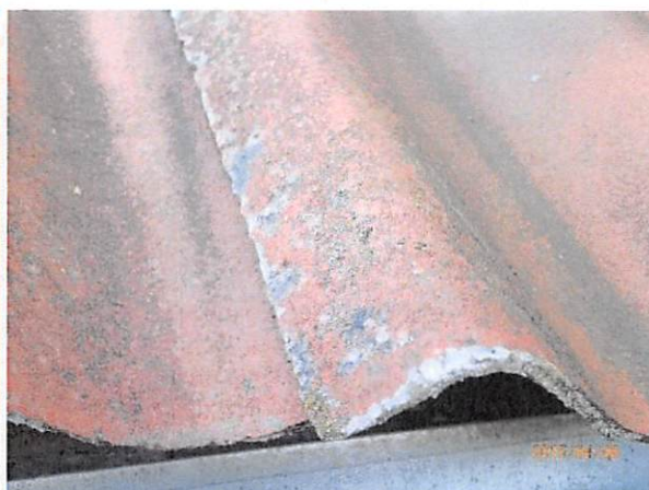
Tagplade materialet de laminere/opløses.
