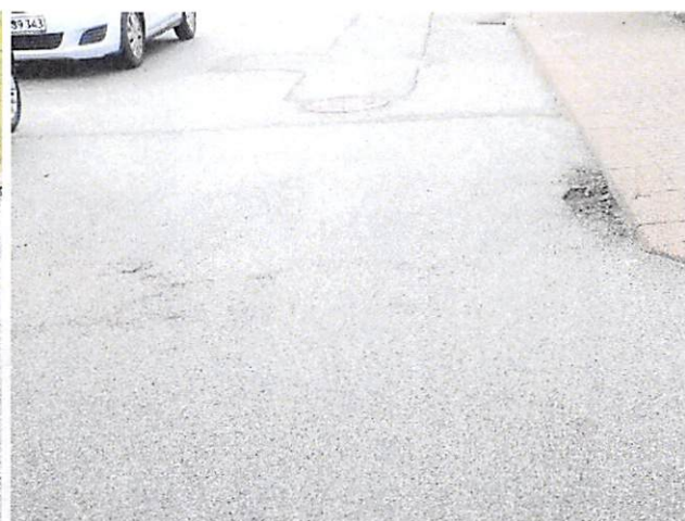
Asfaltbelægning v. nr. 40-93
