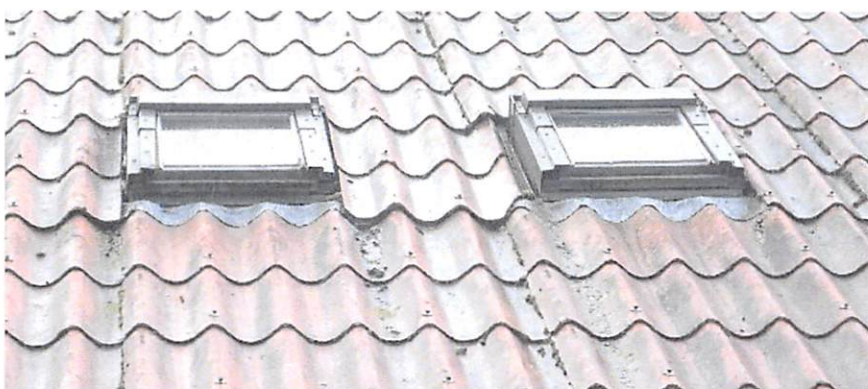
Der er en særlig problemstilling omkring fugt indtrængninger ved ovenlys vinduer – ikke intakte inddæknings forhold + utætte ovenlysvinduer. Tagflader løfter sig samlinger pga. tiltagende mosvækst.
