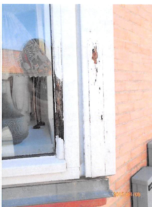
Trædele med tiltagende trænedbrydning.
