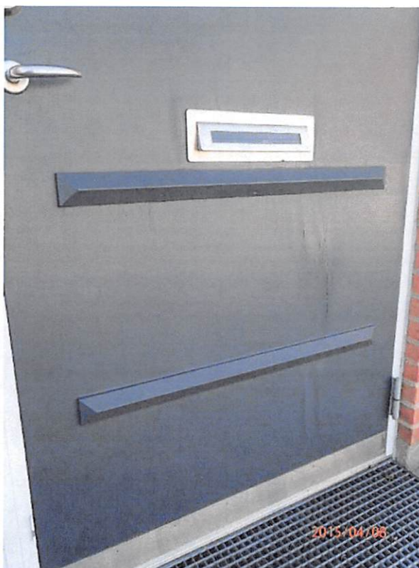
Entredør plader de laminere i de malede finerlag.
