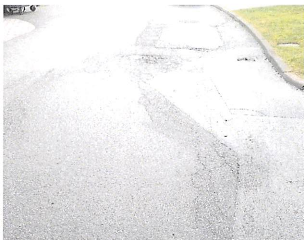
Asfaltbelægning v. nr. 2-36.
