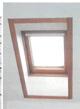
Der er en særlig problemstilling omkring fugt indtrængninger ved ovenlys vinduer – ikke intakte inddæknings forhold + utætte ovenlysvinduer. Tagflader løfter sig samlinger pga. tiltagende mosvækst.
