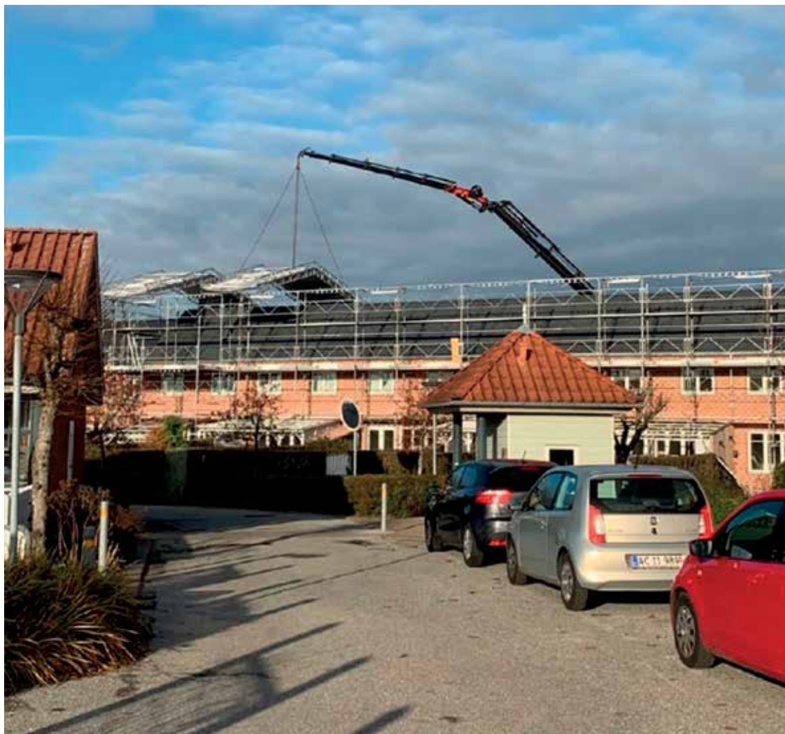
Inddækning af tagkonstruktionen fjernes.
