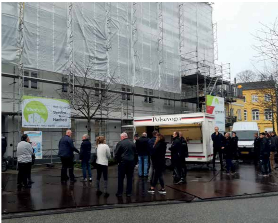
Da taget næsten stod færdigt, kunne vi fejre renoveringen med et byggegilde.
