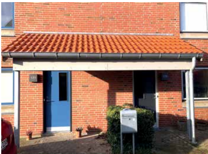
Overdækning af indgangsdøre
