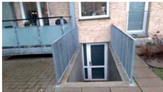
Trappeværn i Odinsgade.
